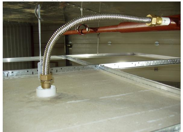
**7.** После установки фрагмента подвесного потолка зафиксировать держатель оросителя патроном
