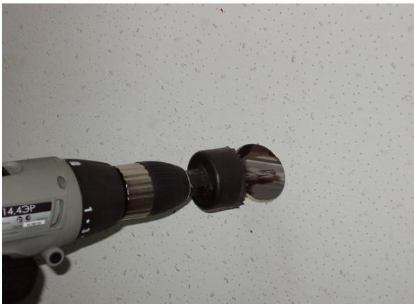
**6.** Вырезать с помощью дрели в материале подвесного потолка отверстие  $\varnothing$  51 мм
