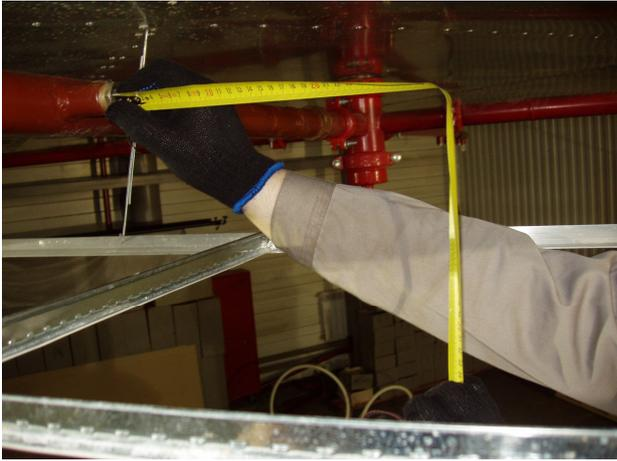
**1.** Измерить длину гибкой UL подводки, необходимой для соединения оросителя с трубопроводом. Рекомендованный радиус изгиба: 203 мм.
