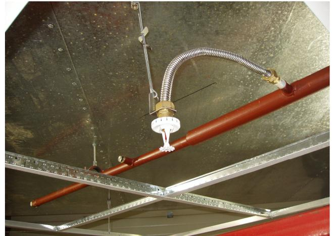
**4.** Закрепить вторую муфту гибкой UL подводки на питающем трубопроводе
