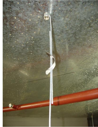
**2.** Закрепить на потолке с помощью дюбеля подвес оросителя.
